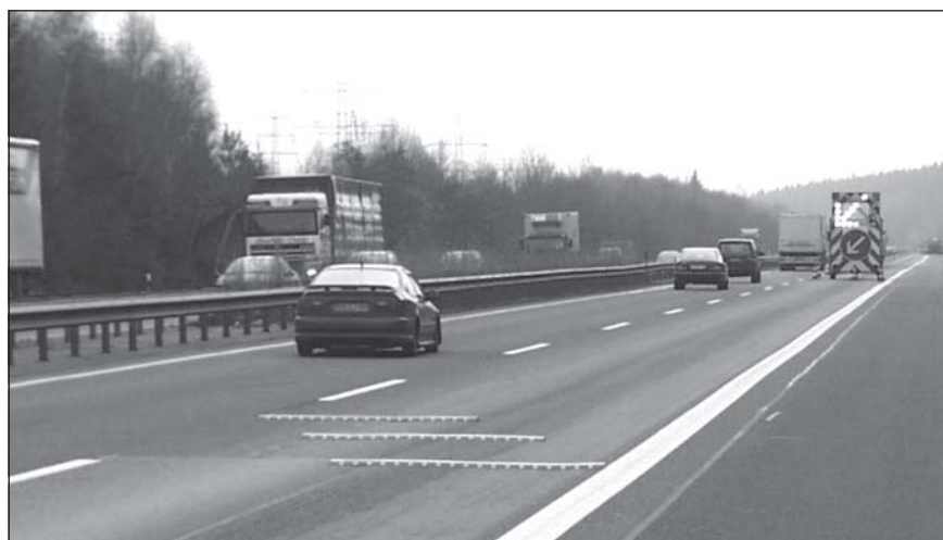
Einsatz von Warnschwellen auf dem rechten Fahrstreifen (Steinauer et al, 2004)
